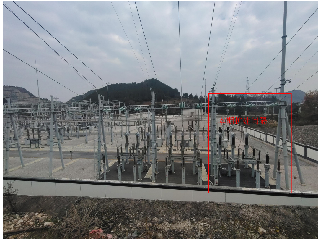
图 4-1 革一变 110kV 出线间隔扩建现场照片
