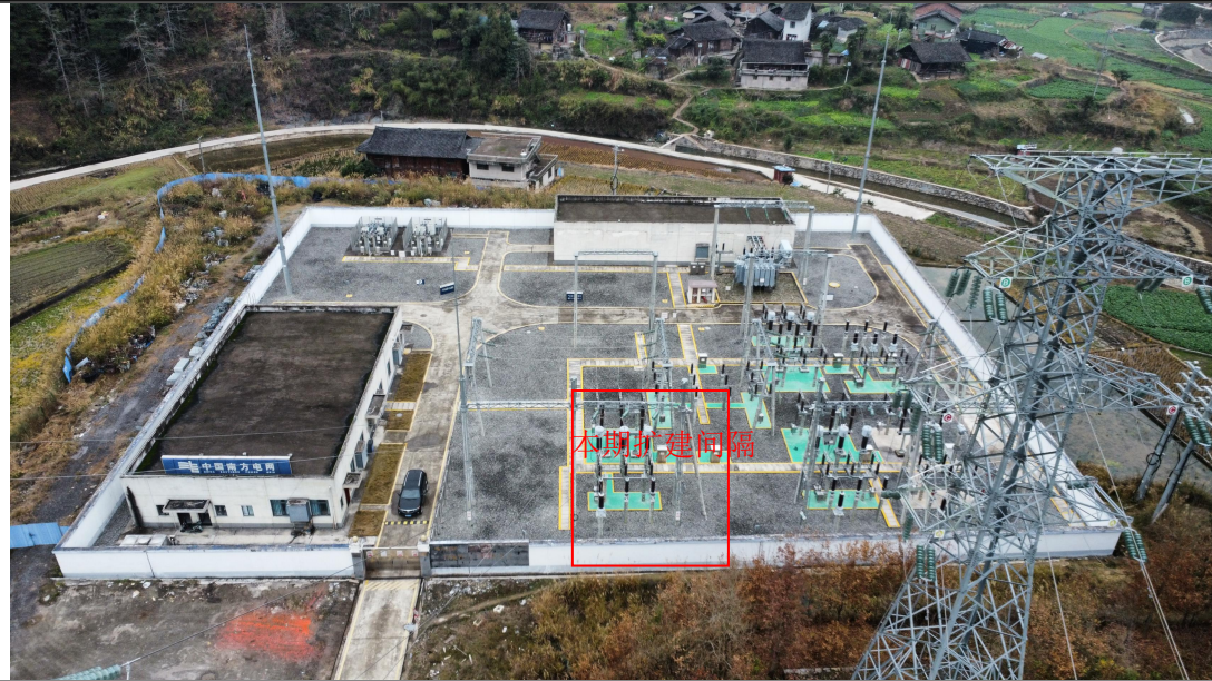
图 4-3 翠文变 110kV 出线间隔扩建现场照片
