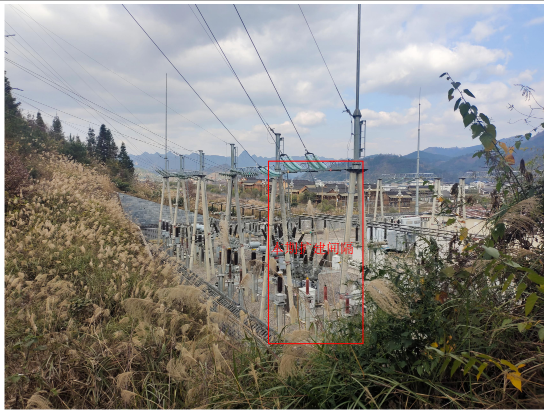
图 4-2 施洞变 110kV 出线间隔扩建现场照片
